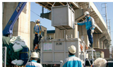
PCB搬出作業
