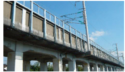
新幹線の防音壁
