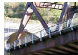
耐候性鋼材を使用した橋梁
